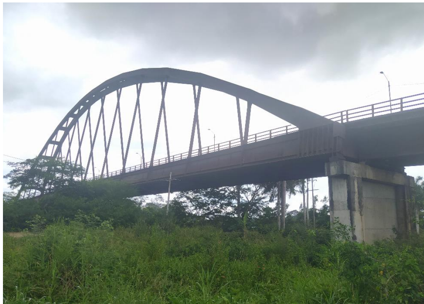
Vista general del puente. Fuente propia.
