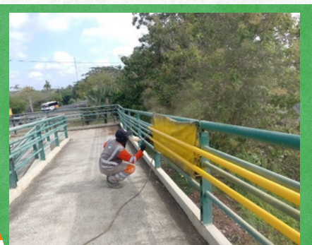
P. Mateo Gómez (Tramo Te Aeropuerto - CAI Cereté)
