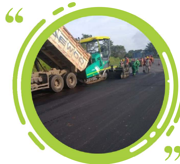
Repavimentación del tramo Cereté - Ciénaga de Oro Calzada Derecha del PR 0+000 al PR 2+000
