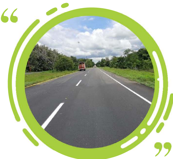
Repavimentación y demarcación horizontal en el tramo La Yé - Sahagún, PR61+000 al PR62+000
