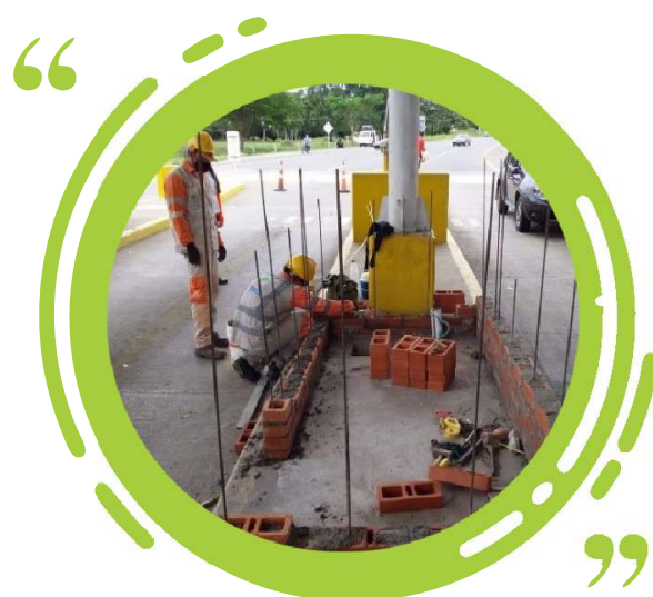
Construcción de caseta en peaje Las Flores, sentido Sincelejo - Corozal.
